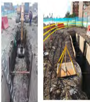
Señalización de Excavaciones y entibados
